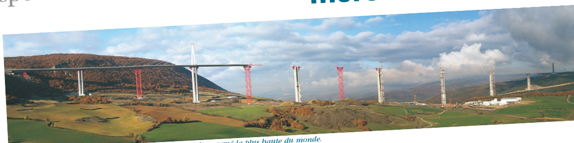
FIG 1. Viaduc de Millau, France. Record de la pile en béton armé la plus haute du monde.
